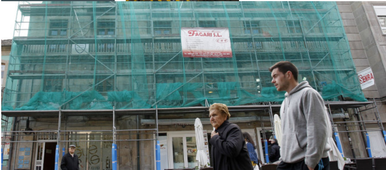
Edificio en obras no centro histórico
