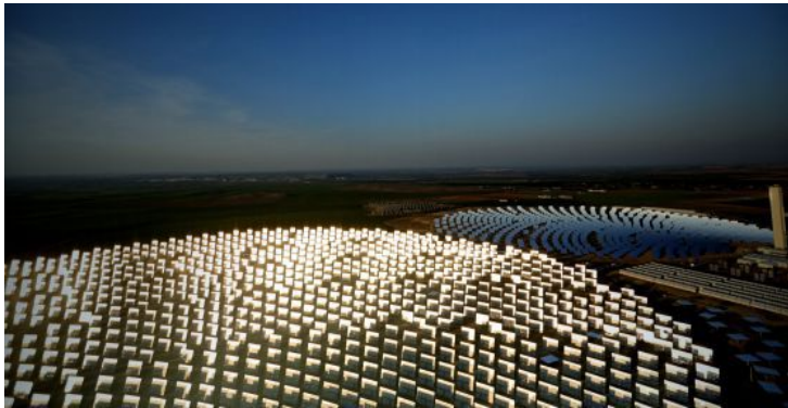
Planta solar de Abengoa. / BERNARDO PÉREZ
