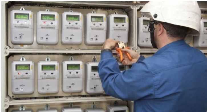
Un técnico instala los nuevos contadores inteligentes.
